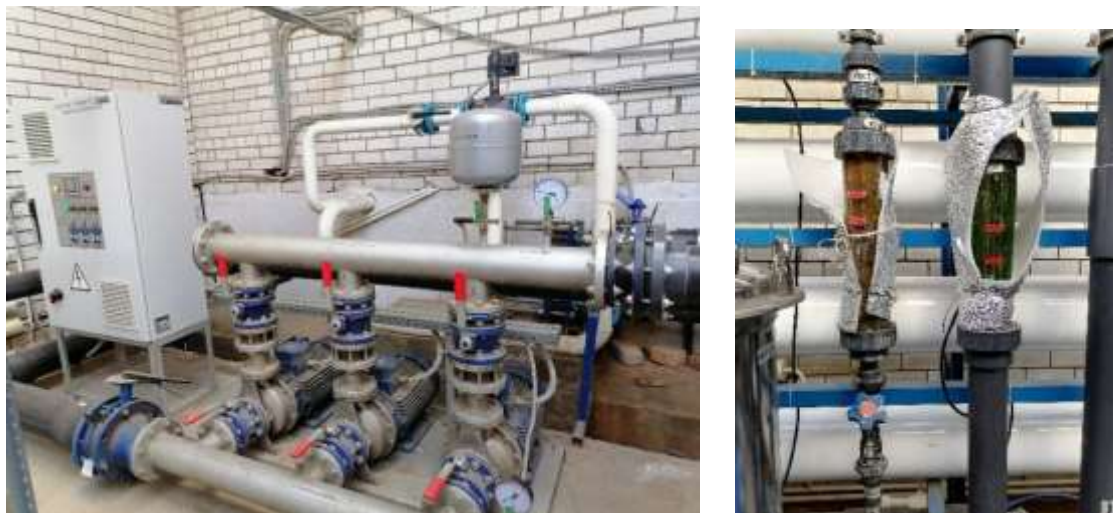
Рис.3. Система насосов и система «впрыскивания» необходимых веществ
